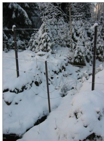
Figur 6. Eksempel på sikring av grøft ved hjelp av supplerende tråder (Foto: Inger Hansen, NIBIO/Norsk viltskadesenter).
