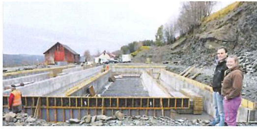
UNDER BYGGING: Det har vært 14 måneder med søknader, bygging og planlegging.
