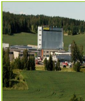
Såkorn behandling (2 anlegg)
