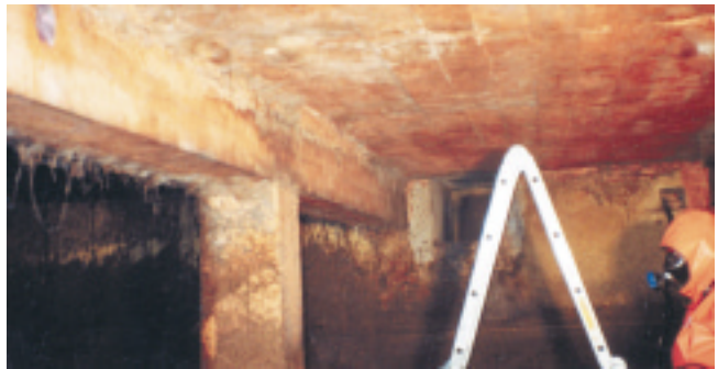
Diffusjonsåpen epoxy-maling er en effektiv karbonatiseringsbremse. Både dekke og drager var overflatebehandla for 13 år siden og behandlinga er utført på enda eldre betong. Målt karbonatisering var 3 mm.
