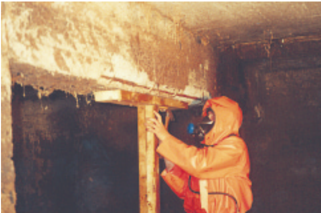
Oppstempling av svekket drager. Denne er utført med 100x100 søyler, 50 x 175 bjelke og kiler som presser bjelken mot konstruksjonen. Kilene må sikres med spiker.
