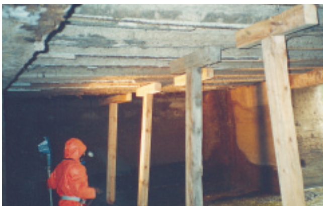
Bildet viser oppstempling av Ribo-dekket på forrige bilde. Oppstemplingen er utført med 100x100 søyle og bjelke. Hver bjelke tar lasten fra to Ribo-dragere for videre drift i en svært kort periode.
