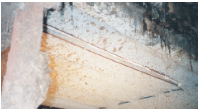
Hva skjer når det blir utført feil reparasjonsmetode? Prosessen fortsetter og sprenger ut.
