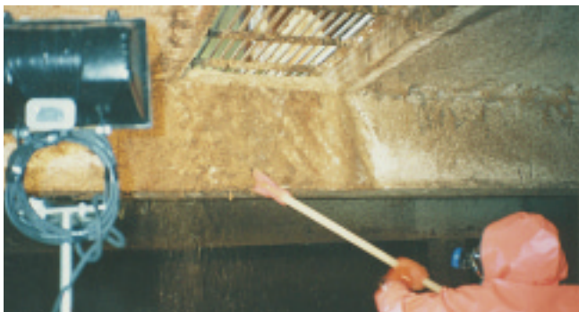
Rengjøring av dragere krever godt lys, skarp-slipt barkes-pade og god arbeidslyst. Husk nødvendig verneutstyr!
