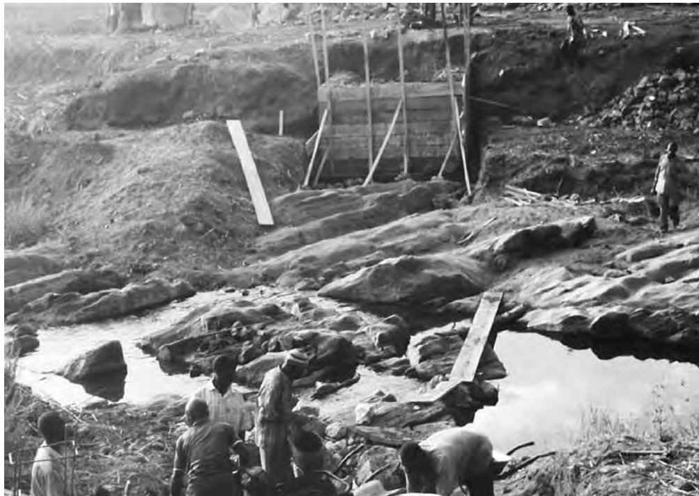
Bygging av bro i Sambolabo, Kamerun
