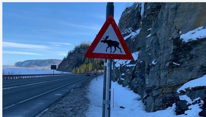
Skilt 146.1 elg montert. FOTO: SKANSKA
